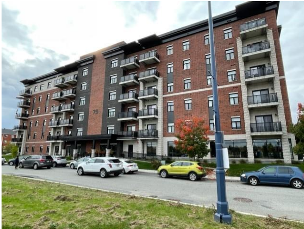
Photo 4.27 – Stationnement en cour arrière de l'immeuble « Square Urbania »
