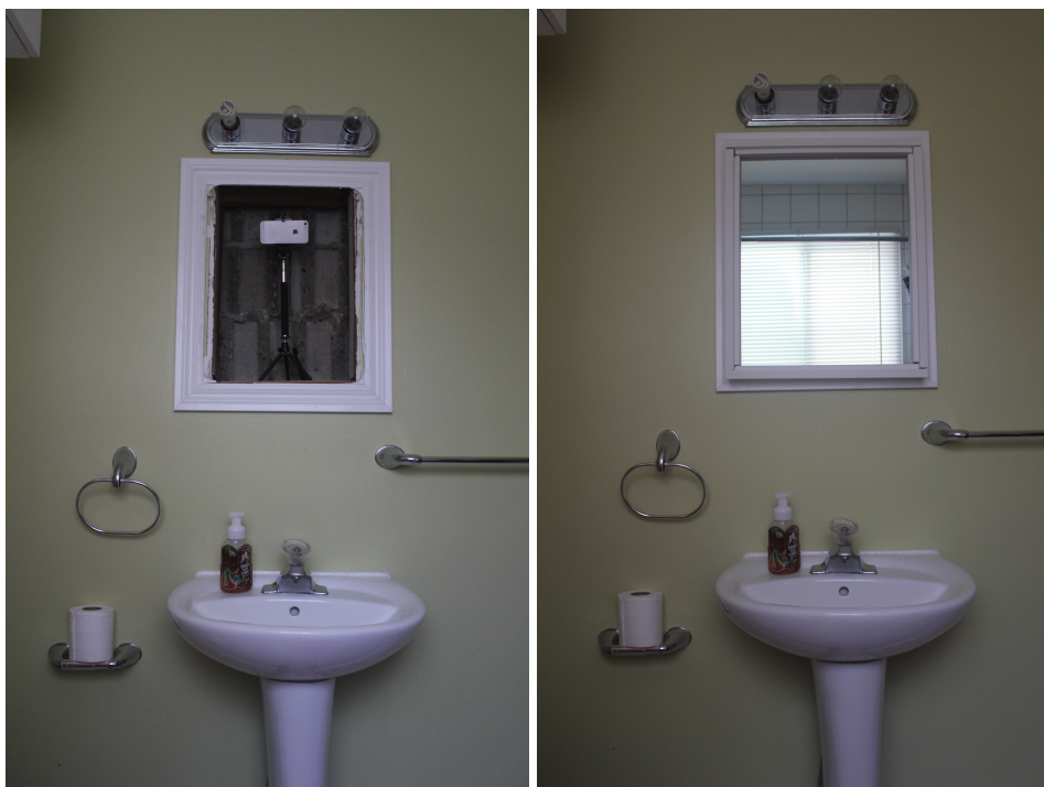
Figure 17 : Installation derrière le miroir de la salle de bain versus point de vue avec le miroir
