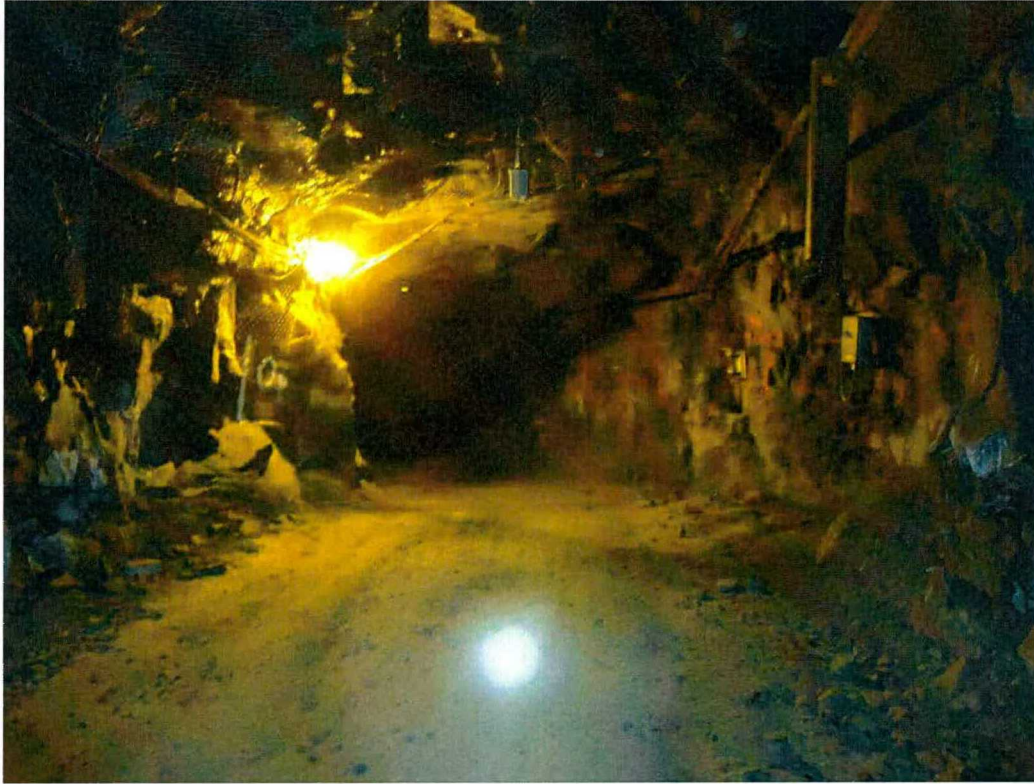
Figure 7. 6 : Bras d'une galerie minière de la mine CANMET
