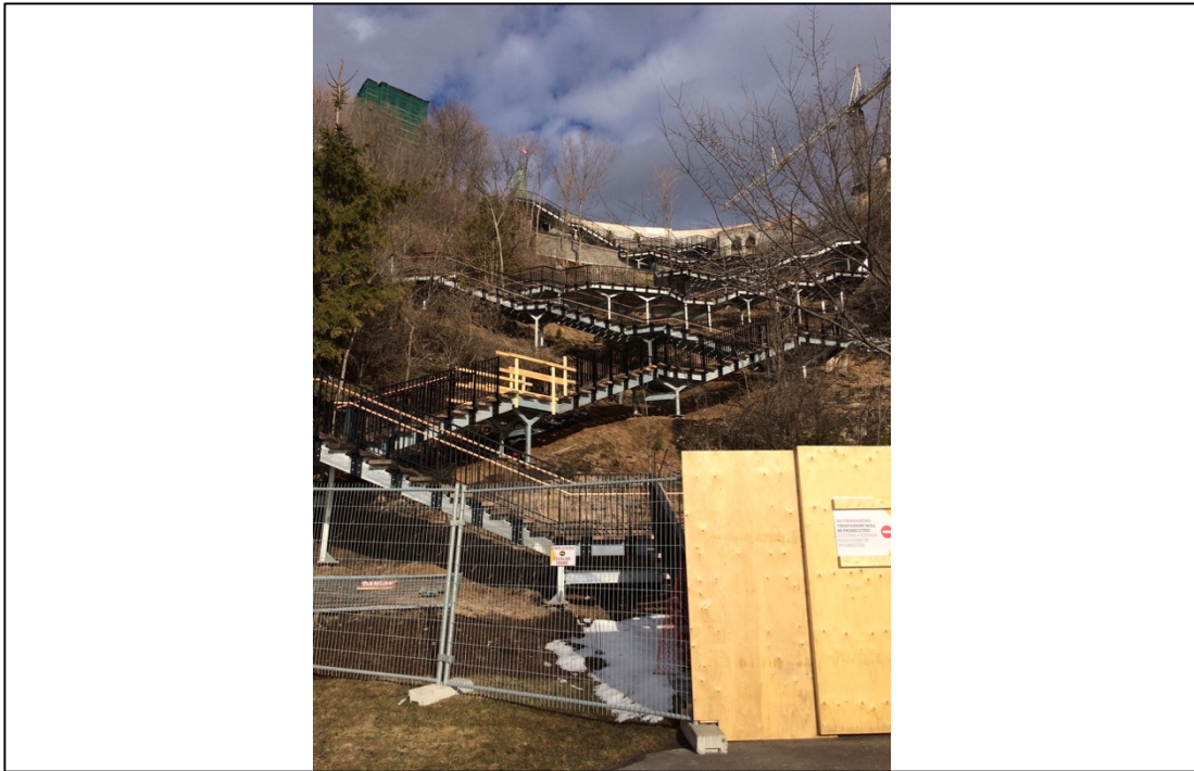
Figure 5.38 EP2 – Escalier en réparation
