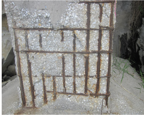
FIGURE 1.4 – Exemple d'un défaut discontinu (barres exposées) qui pose un problème d'annotation où on peut considérer chaque barre comme une instance d'objet, ou bien toutes les barres constituent une seule et même instance d'objet [58].
