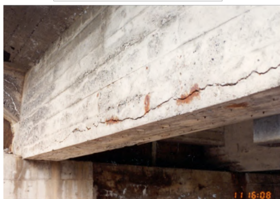
(c) : Délaminage
