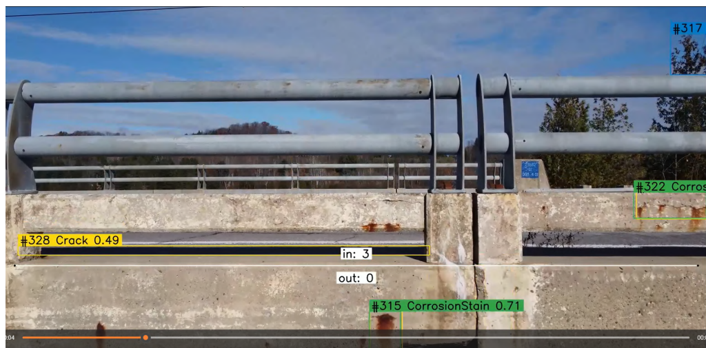
FIGURE 4.11 – Exemple d’inférence par SMDD-Net sur une vidéo prise par drone. En haut à droite, on peut voir que SMDD-Net a détecté un arbre comme étant un objet de classe, ce qui est incorrect. Cette erreur est probablement due à l’éloignement de l’objet.
