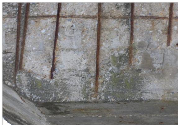
(a) : Corrosion
