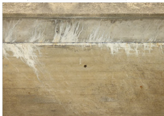
(f) : Efflorescence
