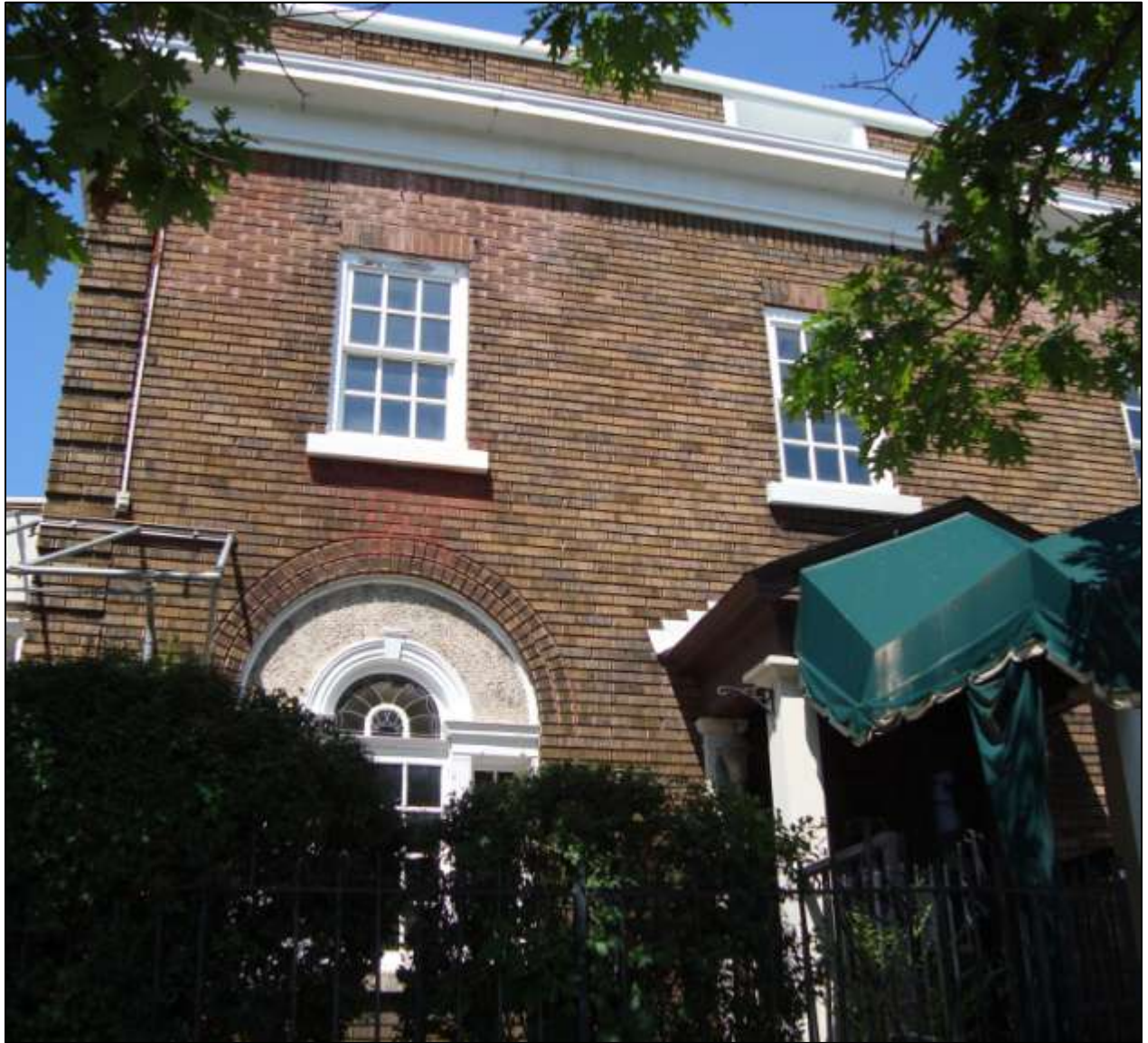
Photographie 3 – Bâtiment du Henry Burger, 69, rue Laurier, au centre-ville de Gatineau (Guylain Bernier, 18 juillet 2022)
