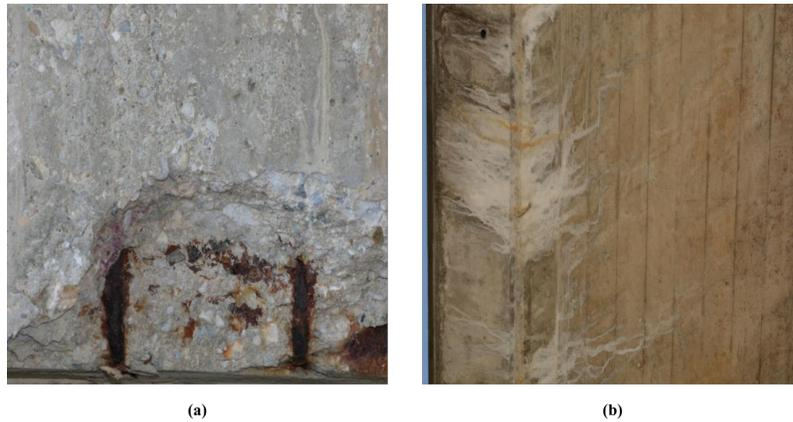
FIGURE 3.3 – (a) : image contenant à la fois de la corrosion et des barres exposées ainsi qu’une dégradation du béton. (b) : Image contenant une efflorescence.
