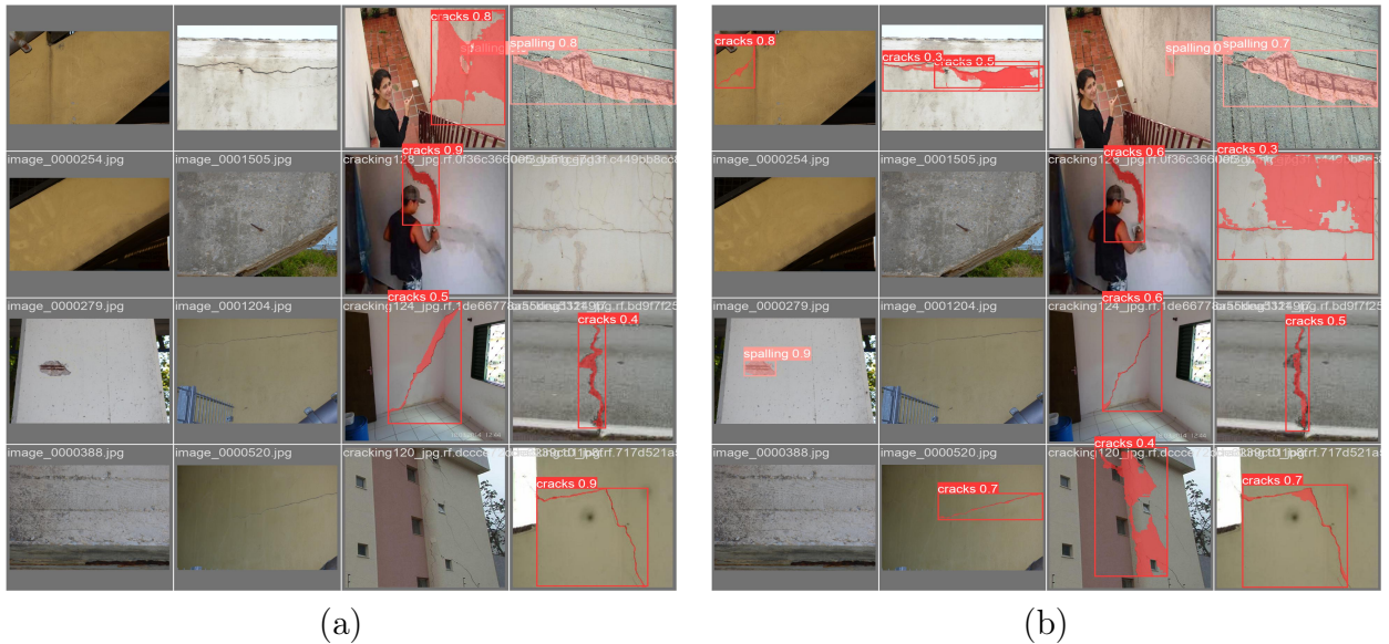
Figure 3.4: Illustration de quelques défis de segmentation des défauts : (a) et (b) montrent la segmentation obtenue par YOLOv7 et YOLOv8, respectivement.
